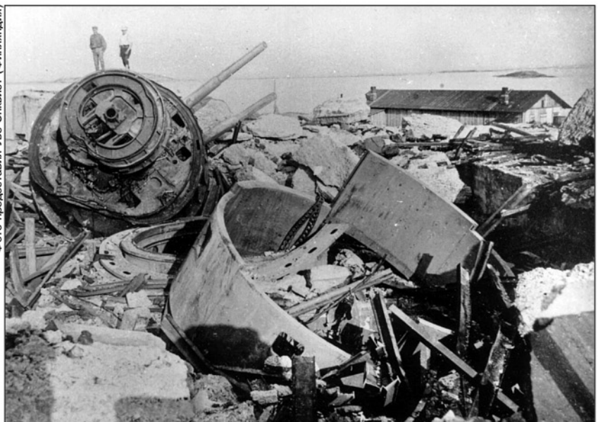
Первая 8-дм. башня батареи №20 после подрыва. На переднем плане вырванная взрывом кираса (неподвижная броня) башни. Начало 1920-х гг.
