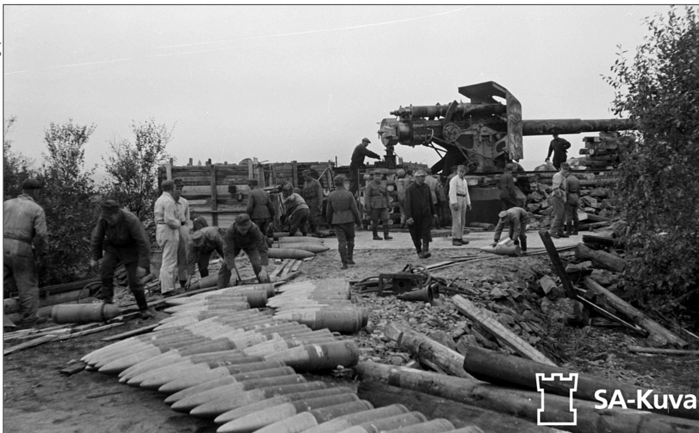
Демонтаж 8-дм./45 клб орудия перед эвакуацией финнов с о. Мякилуото. На переднем плане 8-дм. снаряды с длинными баллистическими наконечниками - колпачками Рикама, названными по имени финского полковника Рикама, предложившего таким образом модернизировать снаряды для увеличения дальности стрельбы. 20.09.1944 г.
