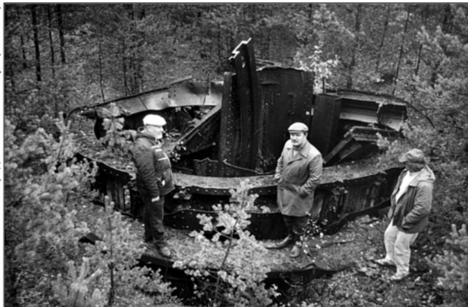
Остатки рабочего отделения, боевого стола и системы подачи с направляющей зарядника второй башни. Фото Мехис Хельме. 1986 г.
