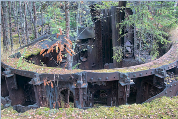
Остатки рабочего отделения, боевого стола и системы подачи второй башни батареи № 9. 2013 г.
