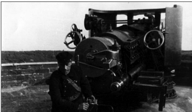
8-дм./50 клб орудие на батарее №10 под Севастополем. Лафет орудия был прикрыт броневым щитом, поэтому в исторической литературе батарею иногда называют «бронелафетной». Начало 1930-х гг.
