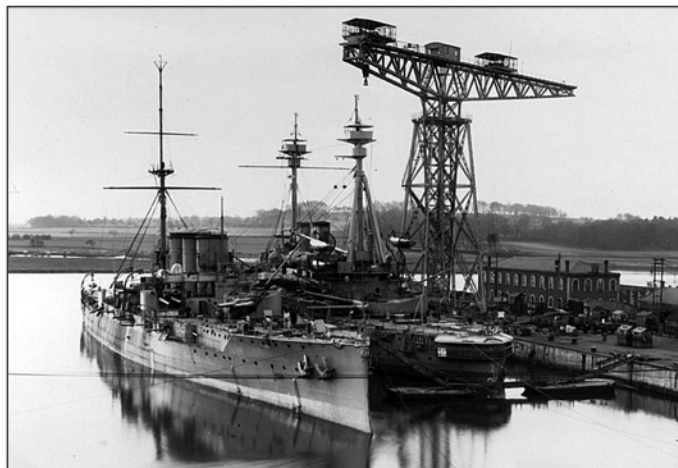
Броненосный крейсер «Рюрик» и броненосец «Агамемнон» на достройке на заводе «Веккерс» в г. Барроу-ин-Фернесс (Англия). На крейсере в 4 башнях были установлены восемь 8-дм./50 клб орудий. Март 1908 г.
