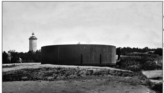
Первая башня. Вертикальные прорезы в кормовой плите башни предназначены, видимо, для прохождения ручных приборчиков. На кормовой плите нанесен №4. На заднем плане нарвгенский маяк. 1938 г.
