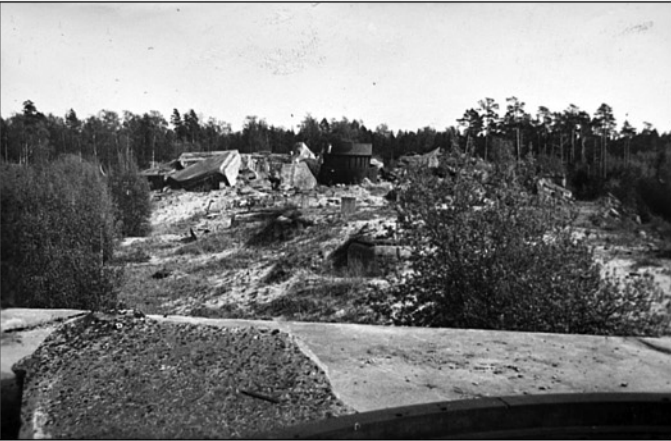
Вид с первого башенного блока на второй. На переднем плане стенка башни, далее — остатки КП, еще дальше — торчащая из бетонных конструкций вторая башня. 1938 г.
