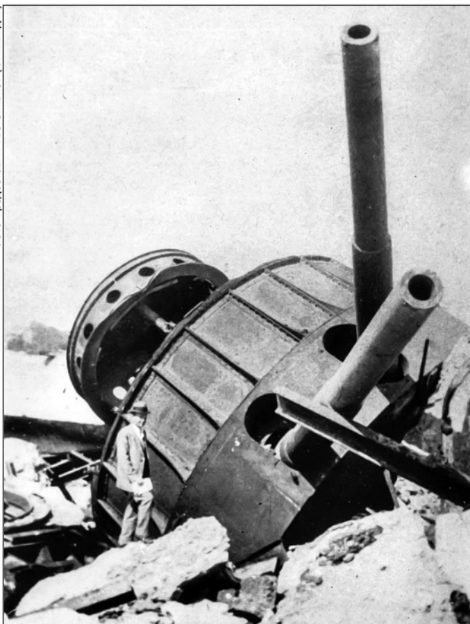
Выброшенная взрывом первая 8-дм. башня. Одно сохранившееся башенное 8-дм./50 клб орудие впоследствии было установлено на станке от 8-дм./45 клб орудия Канэ. Начало 1920-х гг.
