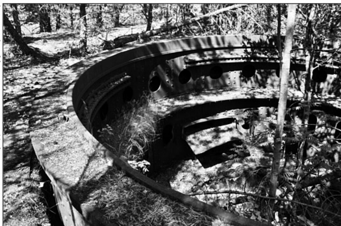
Жесткий барабан первой башни постоянной батареи №9. 2008 г.
