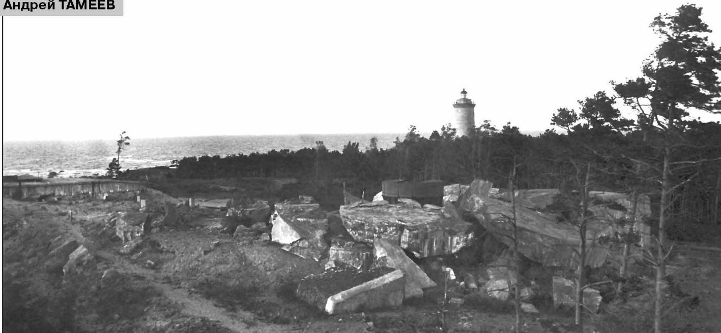
Вид с юга на второй (на переднем плане) и первый (слева в отдалении) башенные блоки батареи №9 на о. Нарген после ее взрыва в 1918 г. В первой башне идет демонтаж орудий. На заднем плане наргенский маяк. Конец 1920-х гг.
