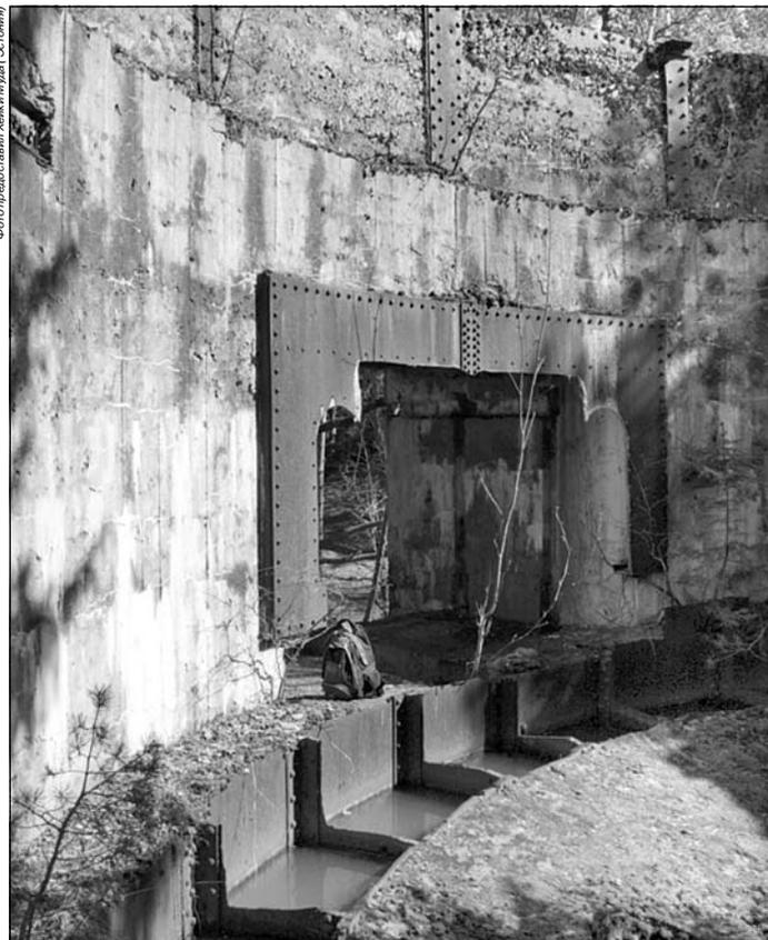
Южный башенный блок батареи №10а. Жесткий барабан башни срезан до пола. За ним видны остатки окон для подачи боеприпасов из погреба в подбашенное отделение. 2008 г.
