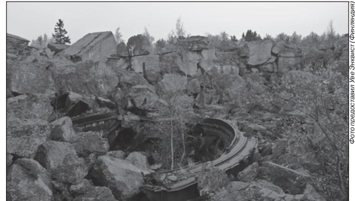
**Остатки жесткого барабана первой башни среди разбросанных взрывом бетонных блоков. 2011 г.**
