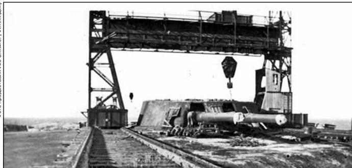
**Окончание монтажа 12-дм. башни. По окончании работ кран будет отправлен для монтажа башни на о. Куйвасаари. Начало 1931 г.**
