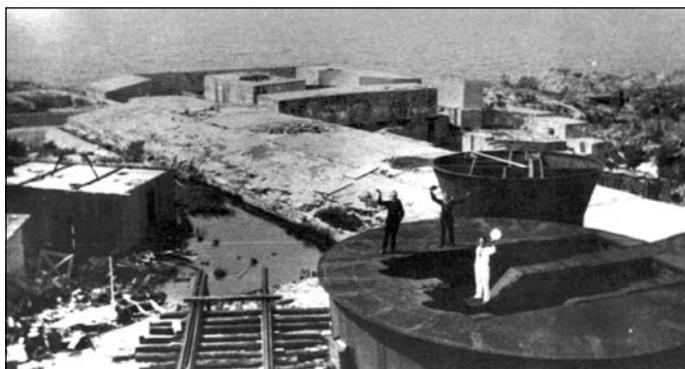
*Вид от первого на второй башенный блок бывшей русской батареи №21 на о. Мякилуото. На переднем плане боевой стол и подачная труба второй 14-дм. башни. Второй башенный блок имеет только стены без бетонного покрытия. 1920-е гг.*
