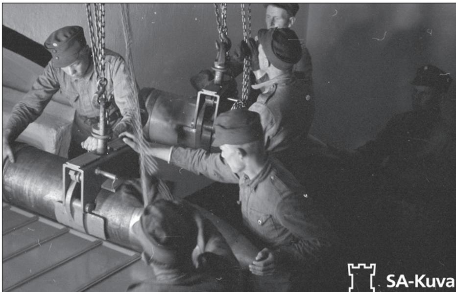
*Слева: Работа в снарядном погребе 12-дм. башни. Подача снарядов на перегрузочный стол для передачи из погреба в подбашенное отделение. На потолке снарядного погреба находился кольцевой монорельс, по которому вручную усилиями двух человек перекатывались тележки с цепными храповыми захватами для снарядов. 9.07.1942 г.*
