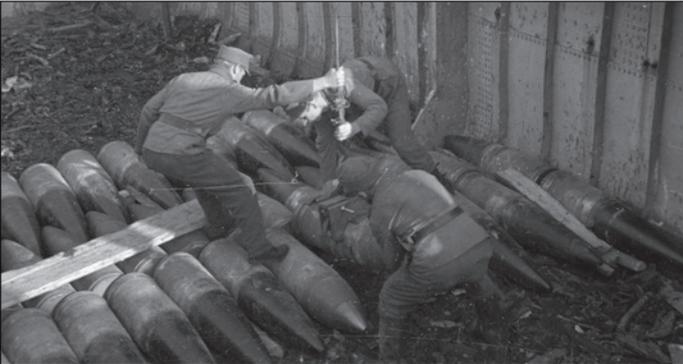
**Погрузка на баржу 305-мм снарядов при эвакуации Мякилуото. С длинными черными носами – модернизированные финнами русские снаряды обр. 1907 г., с более тупыми с латунными наконечниками – русские фугасные снаряды обр. 1911 г. 20.09.1944 г.**
